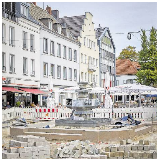
Regionale Baumaterialien wie Grauwacke und Klinker knüpfen an die lokale Baukultur an.
